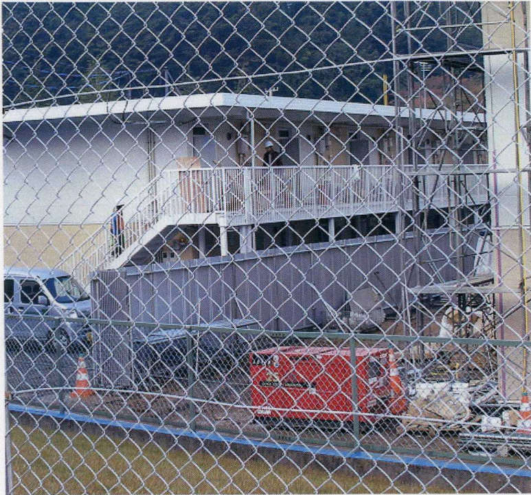
2階建ての仮設住宅
