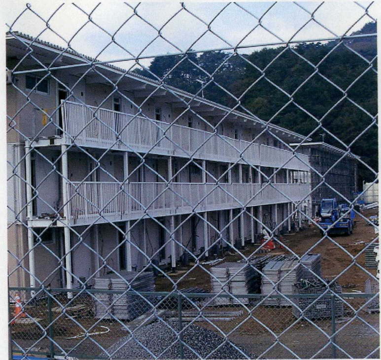
3階建ての仮設住宅
