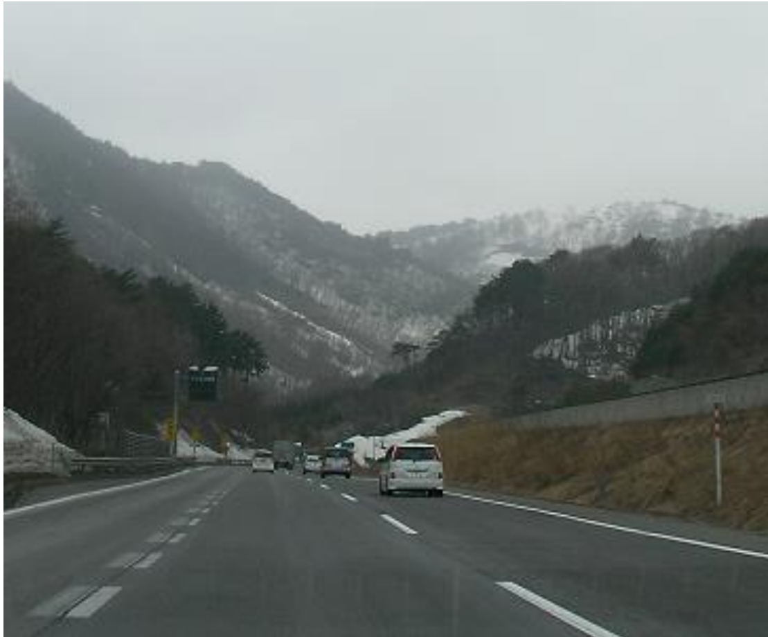
車窓からの磐越自動車道
