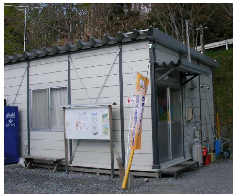
仮設住宅集会所
